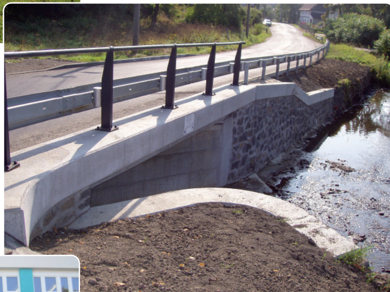
rekonstrukce mostu ve Volfarticích (spolufinancováno z ROP NUTS II Severovýchod)
