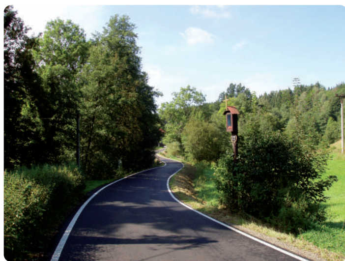
rekonstrukce silnice III/28312 Bělá (spolufinancováno z ROP NUTS II Severovýchod)
