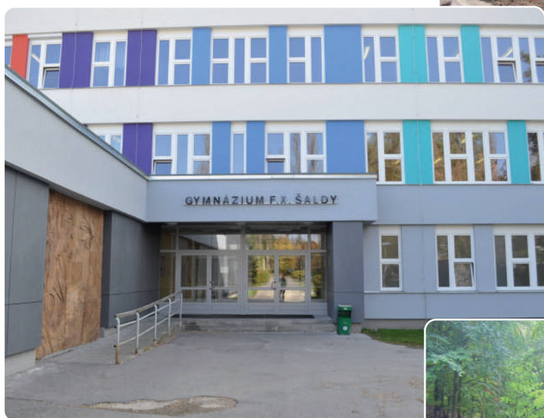
zlepšení tepelně technických vlastností obvodových konstrukcí budov Gymnázia F. X. Šaldy (spolufinancováno z OP Životní prostředí)
