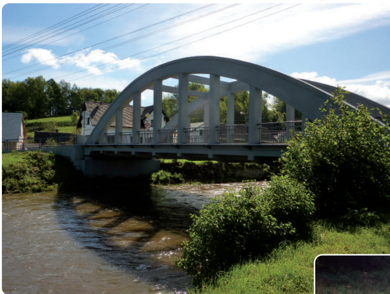
rekonstrukce mostu v Chotyni (spolufinancováno z ROP NUTS II Severovýchod)
