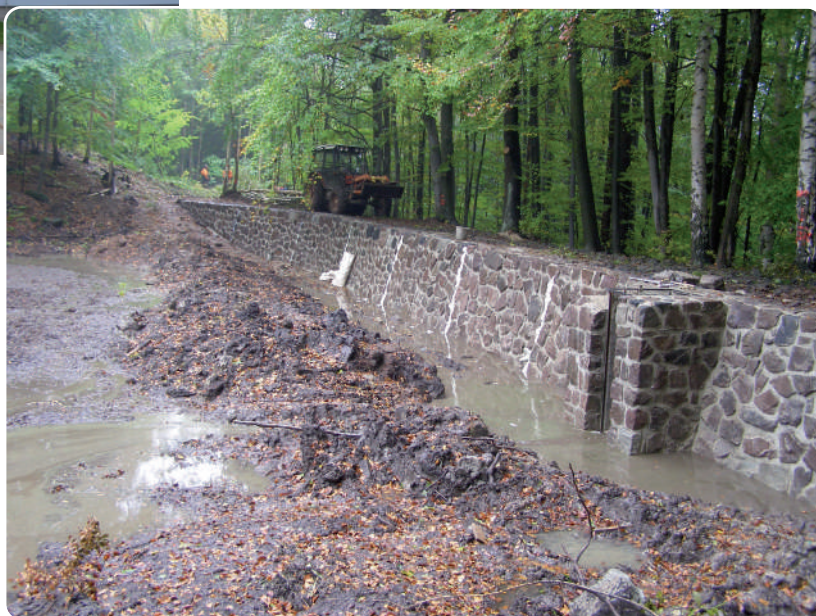
obnova biotopu a rekonstrukce hráze jezírka pod Tábořem (spolufinancováno z OP Životní prostředí)
