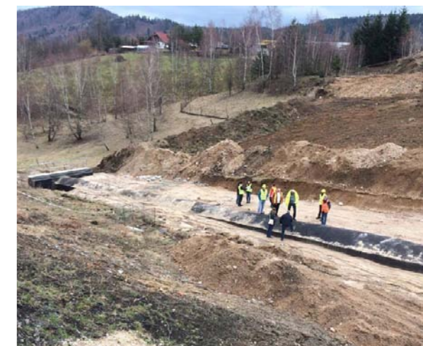
Březen 2016 – Stavba nové silnice z Liberce do sousedního Jablonce nad Nisou
