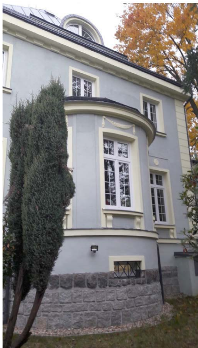
Nové sídlo ZZS LK – Rekonstrukce budovy Neli v Klášterní ulici
