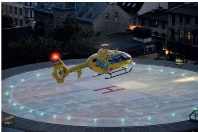
Heliport v areálu Krajské nemocnice Liberec
